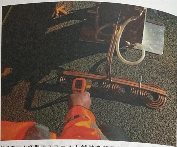
図 オランダで自己治癒型アスファルト舗装を施工してから5年後に供用状況を確認している様子 舗装表面に特殊機器を当てて加熱するだけで劣化を修復できる (写真：山田 敏広)
