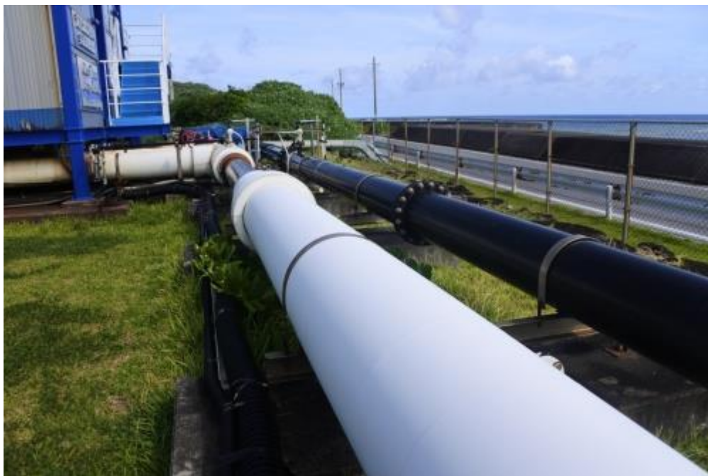
図 4●白いパイプには 8～9℃の深層海水、黒いパイプには 26℃の表層海水が流れている
